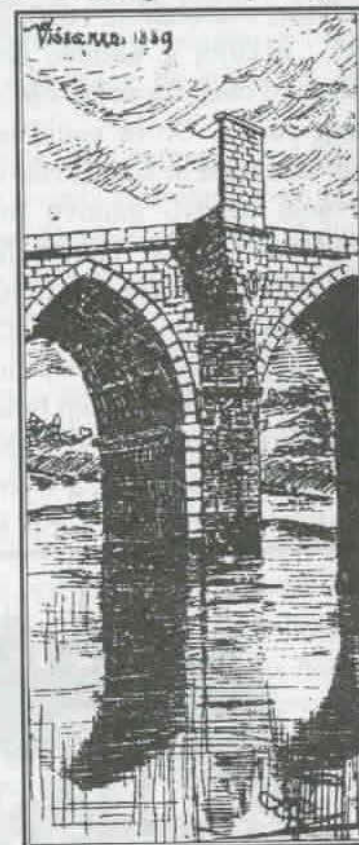
PORTAL NA VIŠEGRADSKOM MOSTU
